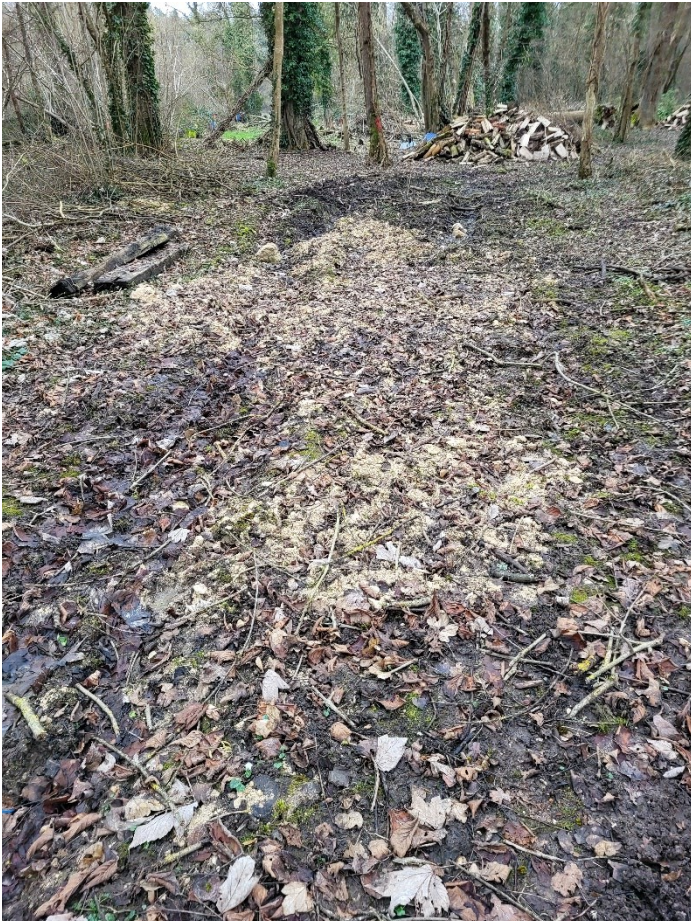
Remblai permettant la création du cheminement sur la parcelle AB216
