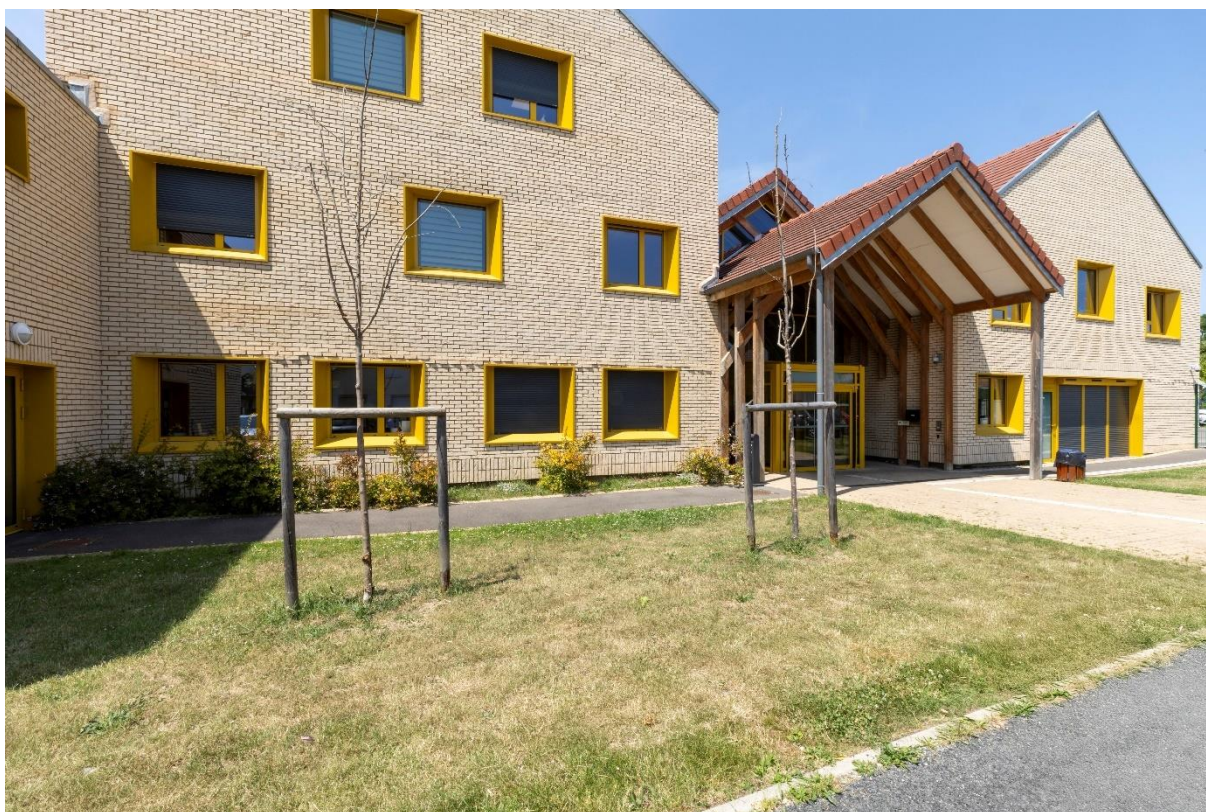
Maison départementale de l'Enfance à Cergy
