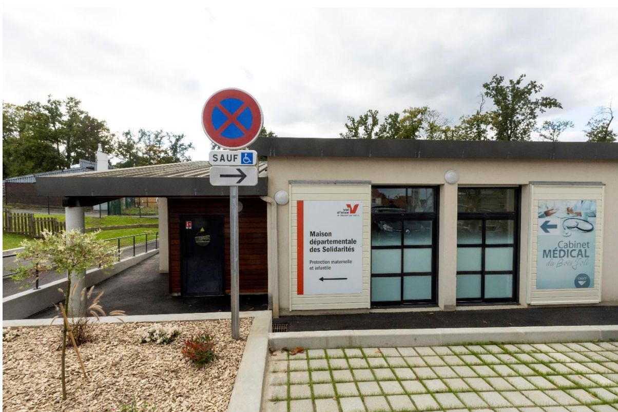
Maison départementale des Solidarités à Osny
