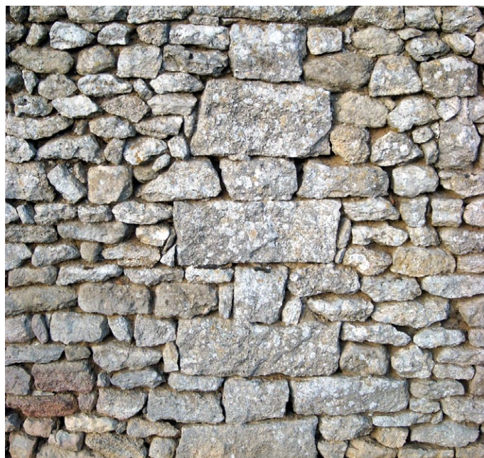
Fig. 56. Mur de clôture en pierres sèches à Vigny : les moellons et les pierres d'appareil grossièrement équarries utilisées pour le chaînage sont en calcaire à algues (quelques moellons sont en calcaire récifal).
