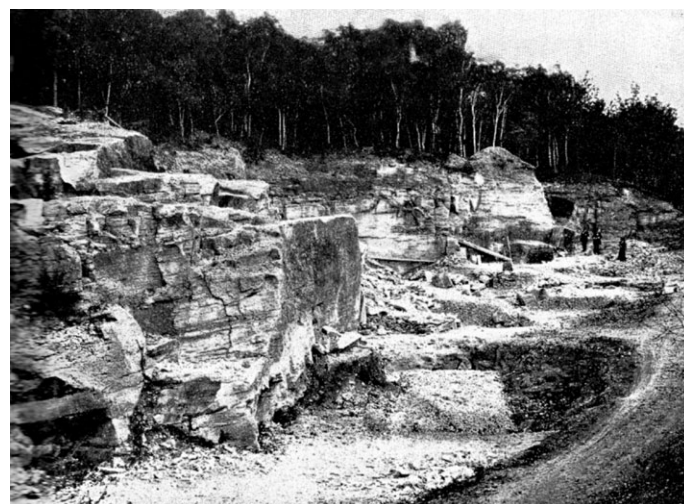
Fig.5. L'exploitation de Vigny au début du XX e siècle [d'après 24]. La photo montre le chantier d'extraction et de taille des moellons du calcaire pisolithique (à grandes strates obliques), alors que celui-ci affleure encore jusqu'en haut du bois des Roches. Son épaisseur totale a été estimée à 25 m [14].
