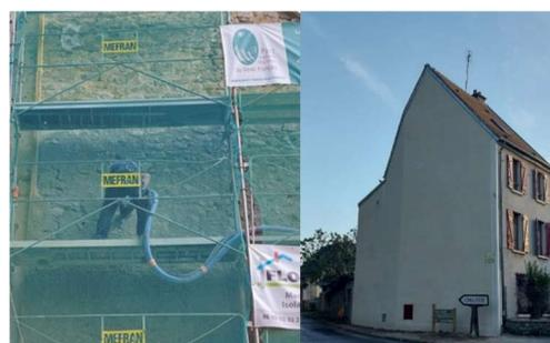
Rénovation d'un mur extérieur par un enduit projeté chaux-
