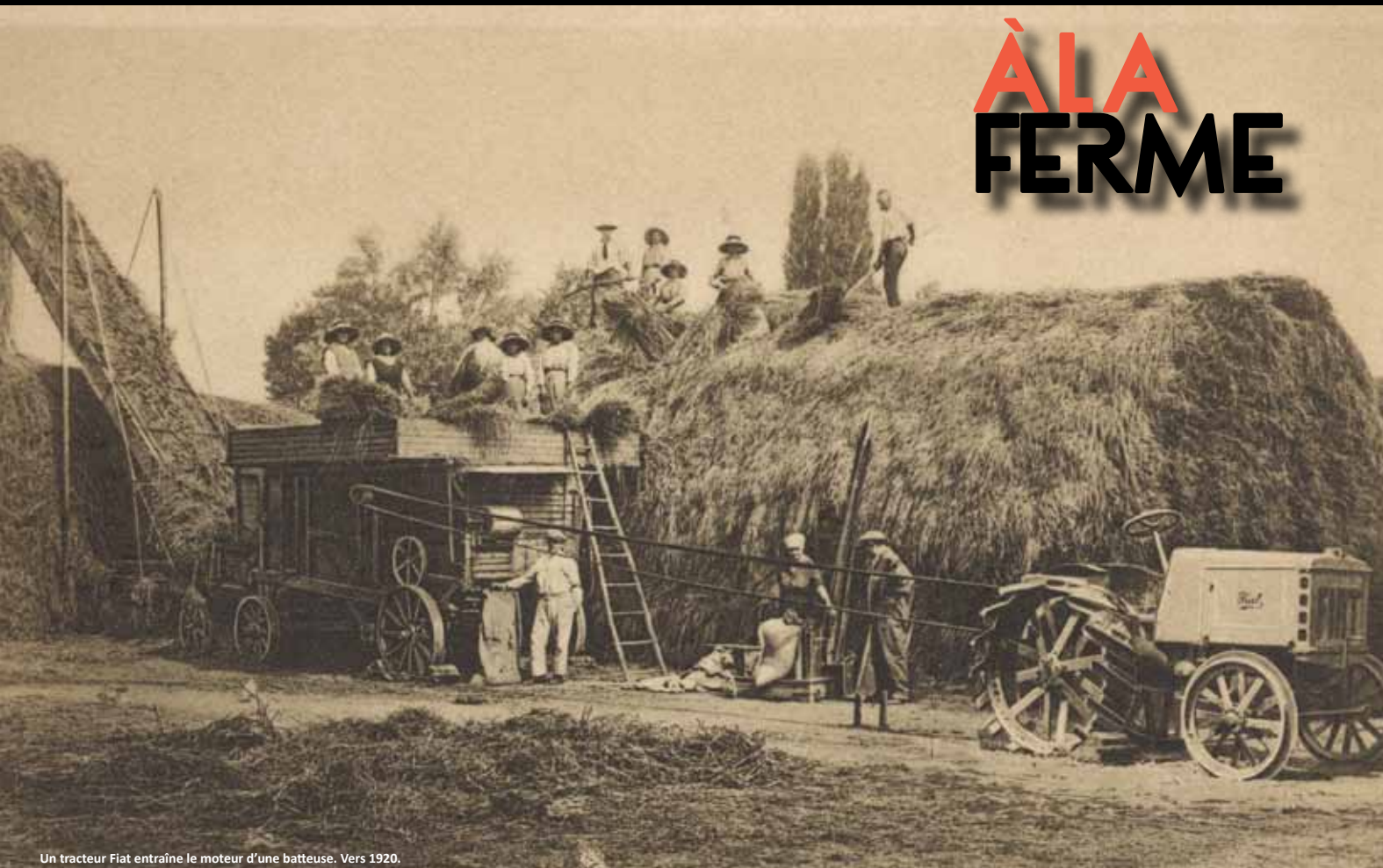
Un tracteur Fiat entraîne le moteur d'une batteuse. Vers 1920.
