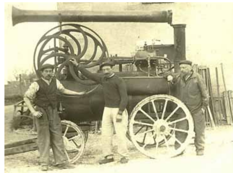
Machine à vapeur. Vers 1910-1920.
