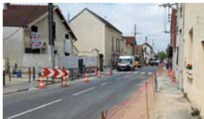
Le Département poursuit le réaménagement de la RD928 à Méry-sur-Oise entre l'échangeur de la RN184 et la voie ferrée (gare de Méry-sur-Oise), sur un linéaire de 600 mètres. L'opération prévoit la remise en état de la chaussée avec le renouvellement de la couche de roulement, la mise aux normes de la voirie (largeurs de trottoirs, places de stationnements) et la réduction des vitesses de circulation (création de plateaux ralentisseurs, vitesse limitée à 30 km/h). Fin du chantier en décembre 2022.
