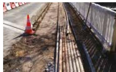
Jusqu'en juin, le Département réalise des travaux d'entretien du pont de la RD 392 surplombant l'autoroute A15. Ils concernent la réfection des accotements et des perrés, la reprise d'une partie de l'étanchéité, le changement des joints et celui des appareils d'appuis. 30 000 véhicules par jour en moyenne circulent sur cet axe qui relie la Patte d'Oie d'Herblay à Bezons.
