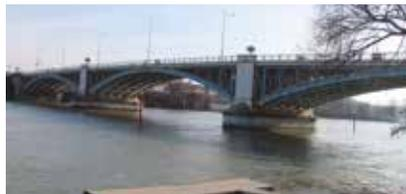
Le Département va lancer dans les prochaines semaines la rénovation du pont de la RD 909 franchissant la Seine depuis Gennevilliers. Cette opération inclut notamment la remise en peinture de l'intégralité de la structure métallique. Elle englobe également la mise en œuvre d'une signalisation dynamique des voies routières qui libérera l'emprise nécessaire à l'implantation de pistes cyclables.
