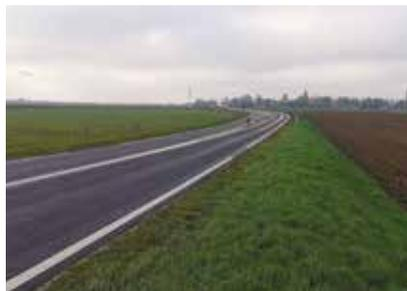
Le Département a réalisé la sécurisation d'un virage de la RD165 à hauteur d'Epiais-lès-Louvres. Ces travaux intègrent une solution innovante, le Guid'n Grip®. Il est constitué d'un revêtement routier à haute adhérence associé à des plots Led balisant la courbe du virage. Leur déclenchement est géré par un radar détectant les véhicules en approche. **350 000 euros investis par le Département**
