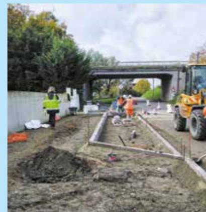
Le Département réalise à Vémars des aménagements pour sécuriser les circulations piétonnes sur la RD 9. Démarrés début octobre, les travaux concernent le tronçon compris entre l'avenue des 10 Arpents et la rue de la Pointe d'Aumont. Ils comprennent la réfection de la chaussée et des trottoirs, la création de deux chicanes, le marquage au sol et la signalisation verticale... Fin du chantier en février. Cette opération est financée par le dispositif départemental des Aides aux communes.
