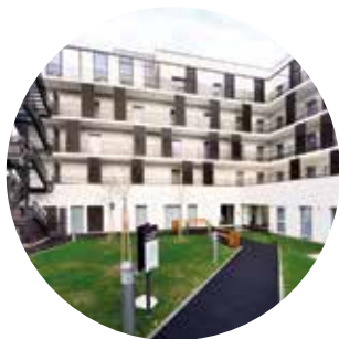
Résidence de la rue John Lennon à MONTIGNY-LÈS-CORMEILLES 01 30 40 23 00 sec2.montigny@orpea.net
