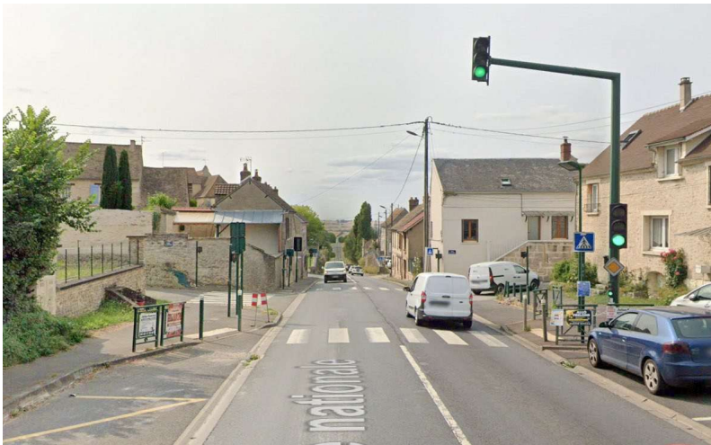
Figure 1 : Le carrefour à feux entre la RD14 existante et la rue de Parnes (source : Google maps)
