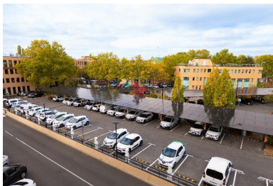
Nouvelles ombrières sur la parking du campus © Département du Val d’Oise
