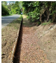
Crapaud RD92 à Montgeroult © Département du Val d'Oise
