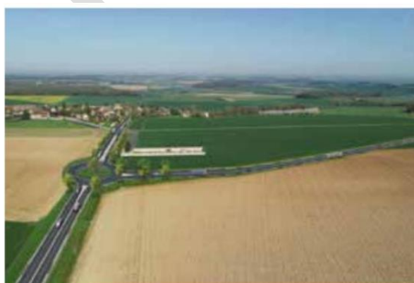
Vue aérienne de la Chapelle-en-Vexin
